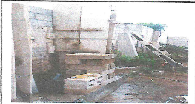
Foto 1: muro perimetral en proceso de reforzamiento de columnas que servirán de refuerzo a la sostenibilidad del muro.
