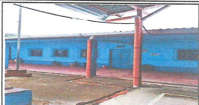
Foto 2: canales recolectores de aguas pluviales ya colocados estando pendiente fundición de cementos en tubos recibidores de aguas para su respectivo drenaje.
